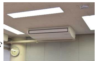
【エアコンが設置されました。】
